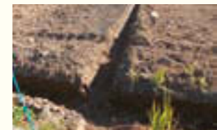
排水溝設置事例
